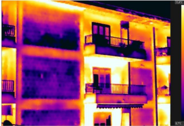
Ponte termico parete solai NON isolato
