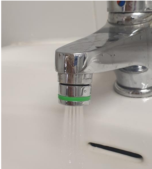
Installazione di dispositivi rompigitto per ridurre il consumo di acqua (giugno 2023 e giugno 2024)
